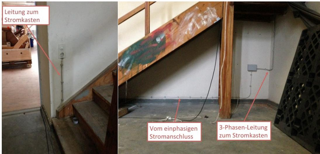
Abbildung 3: Stromanschluss am Treppenaufgang
