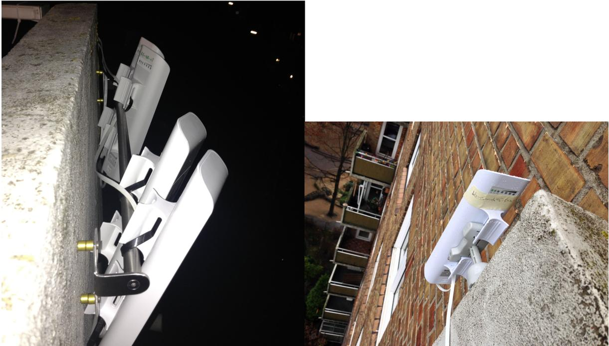
Abbildung 2: Sektorantennen, die das Signal in der Nachbarschaft verteilen, sowie Richtfunkantenne zum Standort "fux"
