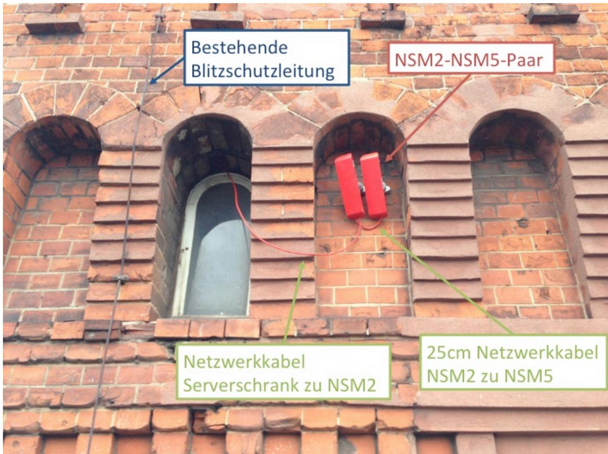
Abbildung 5: Beispiel für Sektorantenneninstallation, Sektor 1
